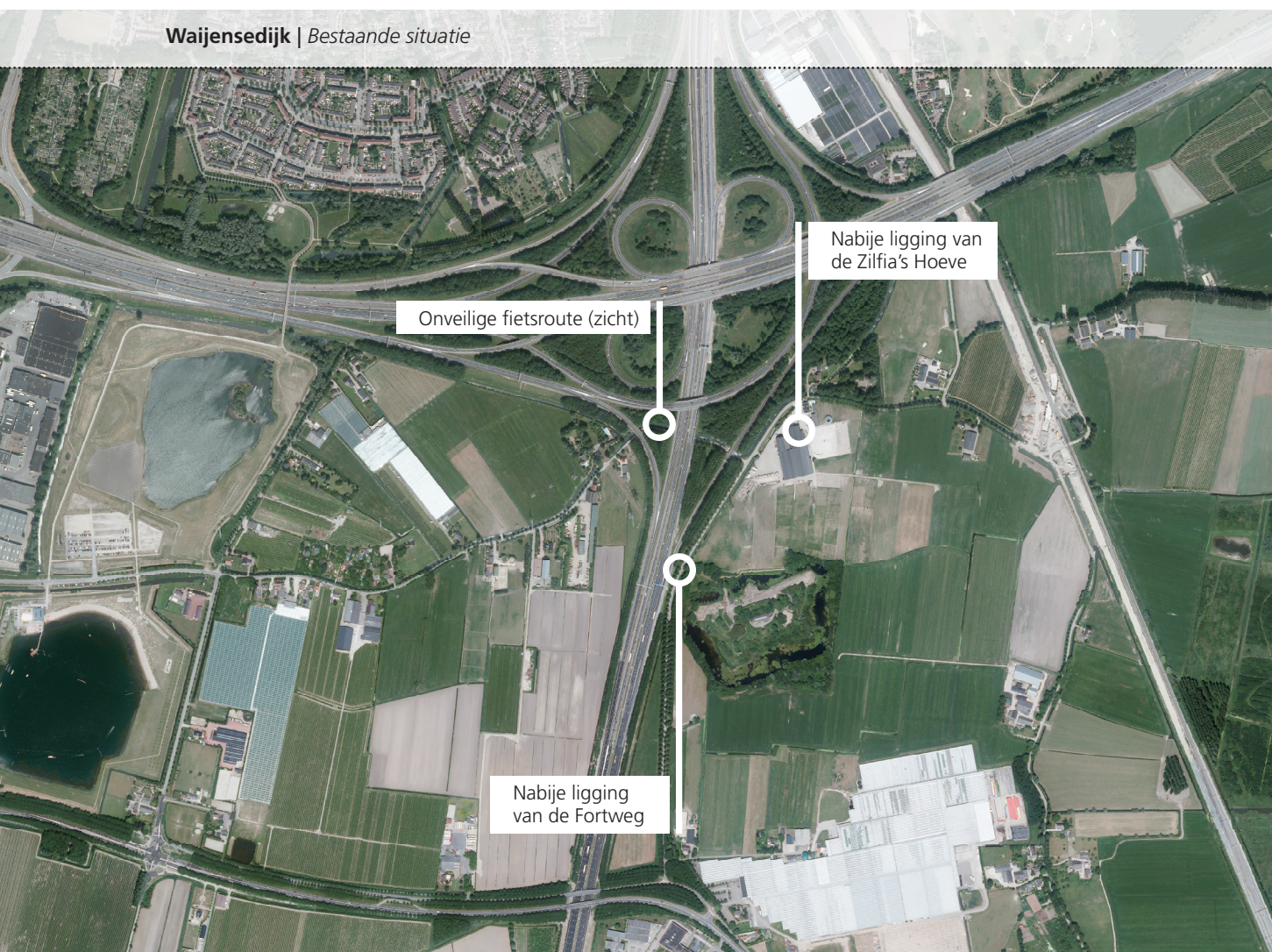
Afbeelding 4.2 Bestaande situatie Waaijensdijk - luchtfoto 2011.
