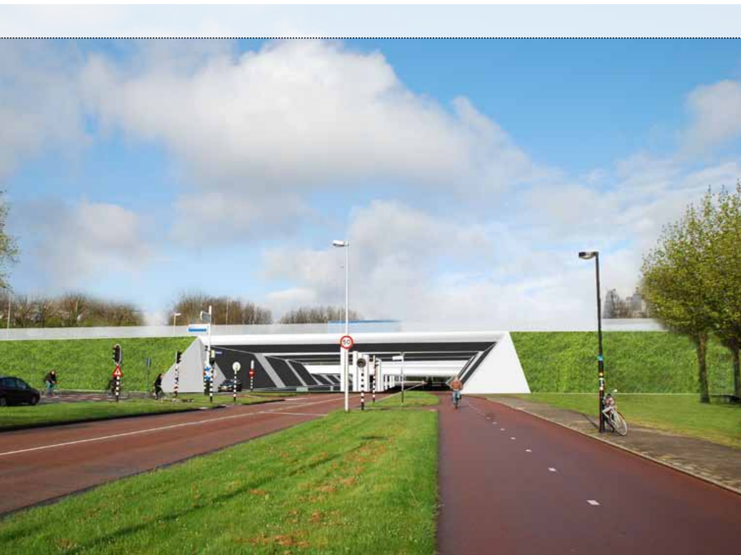
Afbeelding 8.7 Viaduct A27 bij Variant D, gezien vanaf de Leuvenlaan.
