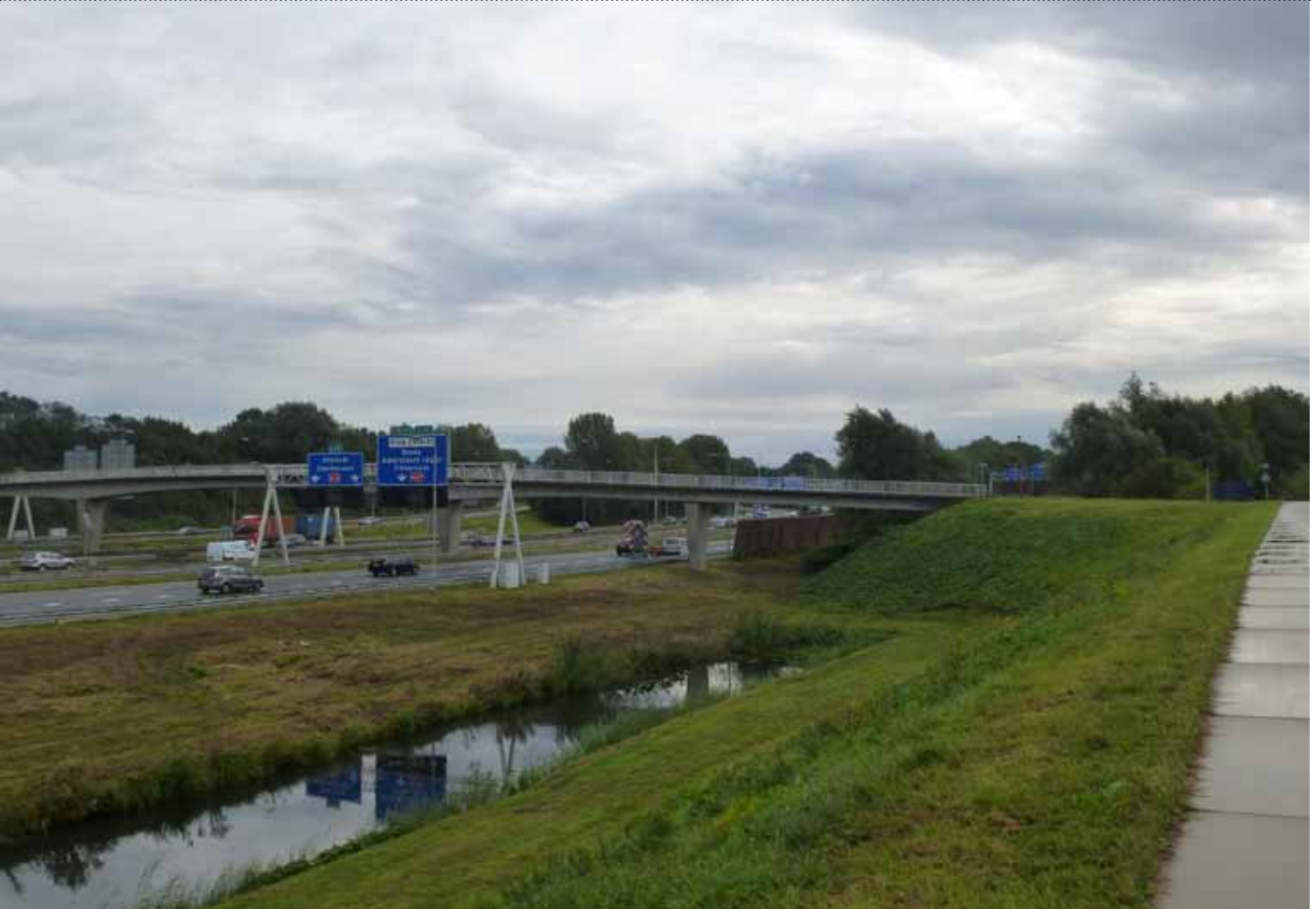
Afbeelding 13.2 Bestaande situatie fietsbrug over de A12, gezien vanaf het zuiden richting knooppunt Lunetten.
