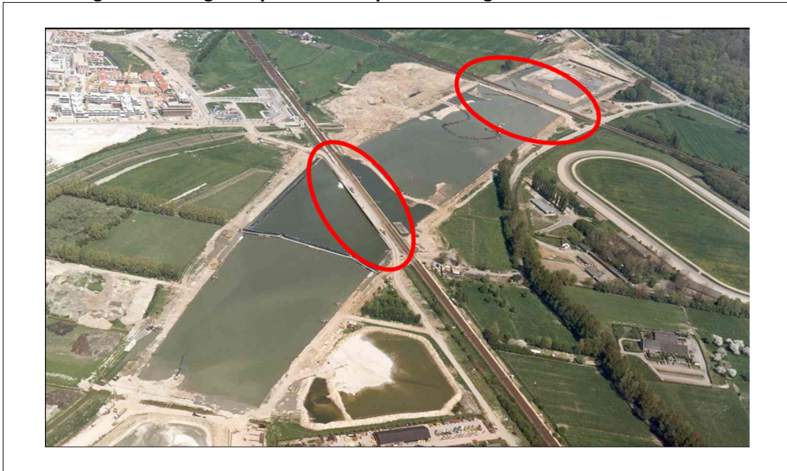
Afbeelding 1.1. Aanleg foliepolder met spoorkruisingen 1983
