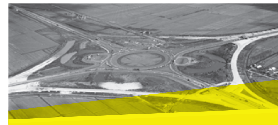
Knooppunt Oudenrijn in aanbouw
